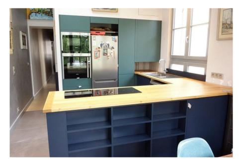
A Travers Fil a travaillé sur une cuisine existante afin de refaire un plan de travail ainsi que les façades. Le plan de travail est en bois massif (essence robinier) assemblé avec rainures fausse languettes et une finition à l'huile de lin. Les façades et portes ont été réalisées à partir de médium de réemploi. Le médium a été récupéré grâce à Re'Up pour être peint dans les coloris choisi par les client.e.s.
