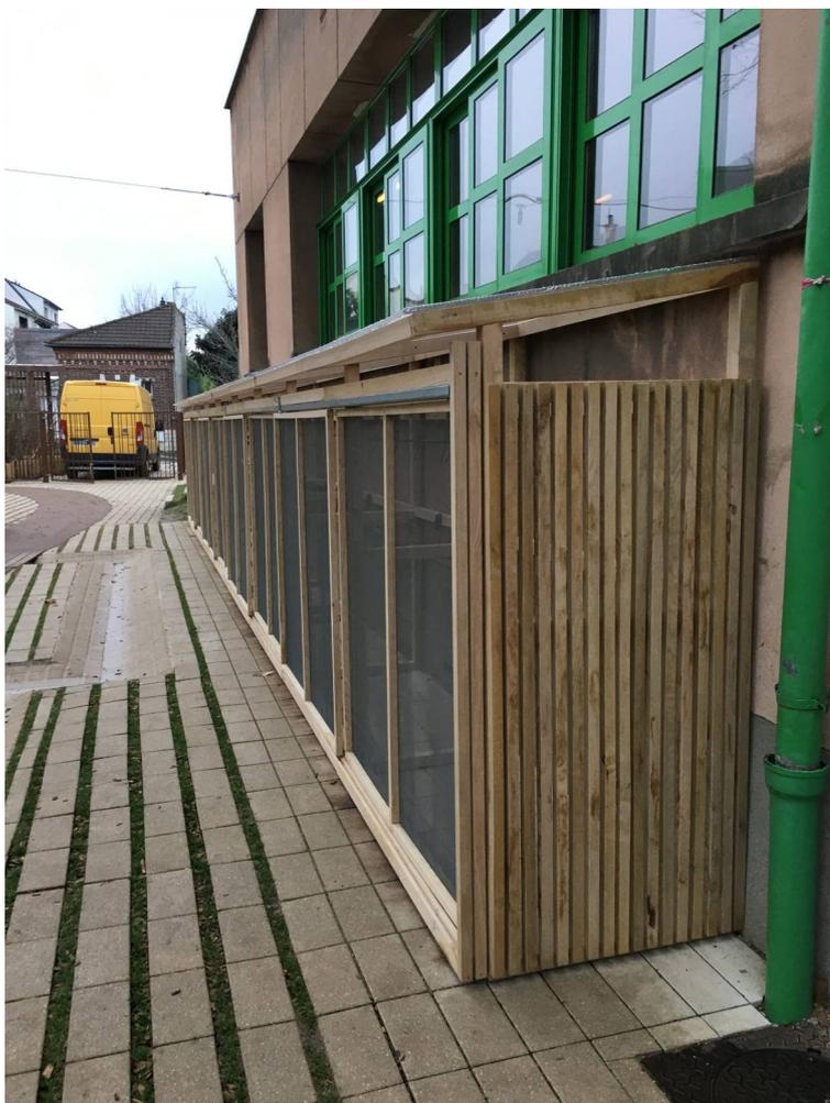
Pour une cour d'école à Cachan, ATF a imaginé et conçu une armoire à draisienne de 12 m de long pouvant accueillir 47 draisienne ! L'armoire a été réalisée à partir de bois massif, du châtaignier, provenant de Picardie, avec une toiture en polycarbonate et des portes coulissantes grillagées. La maîtrise d'œuvre est assurée par l'agence Complémenterre. Montant 8 490€ HT.
